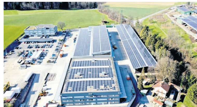
Beispiel für ein Grossprojekt: Convoltas installierte 2020 bei Risi Immobilien AG in Baar eine Fotovoltaikanlage. Bild: PD
